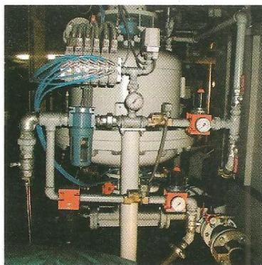
Bild 2. Bindemittel-Injektor am Kühler
